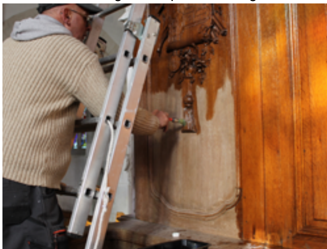
Pose d'une grosse couche d'huile de lin sur les 140 m 2 de boiseries en chêne que constituent les panneaux et les bancs qui ornent le chœur de l'église. Ces panneaux datent, pour la majeure partie, de 1536, travaillés par 6 menuisiers pour la basilique du Valasse, jadis partie intégrante de l'Abbaye du Valasse, avant d'être installés dans notre église Saint Thomas Becket. Ils retrouvent aujourd'hui une belle couleur huilée et une nouvelle protection contre les uv et les insectes xylophages.
