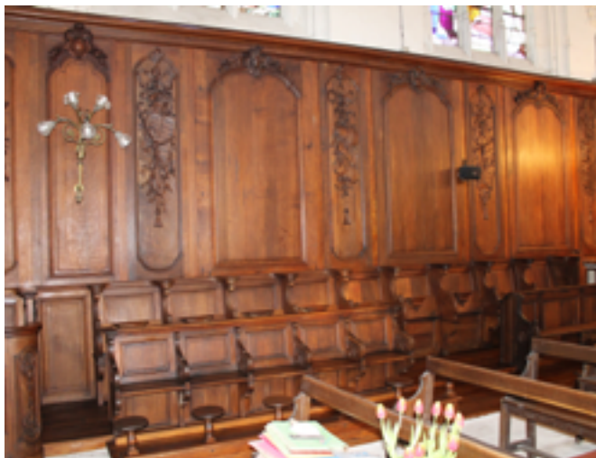
Pose d'une grosse couche d'huile de lin sur les 140 m 2 de boiseries en chêne que constituent les panneaux et les bancs qui ornent le chœur de l'église. Ces panneaux datent, pour la majeure partie, de 1536, travaillés par 6 menuisiers pour la basilique du Valasse, jadis partie intégrante de l'Abbaye du Valasse, avant d'être installés dans notre église Saint Thomas Becket. Ils retrouvent aujourd'hui une belle couleur huilée et une nouvelle protection contre les uv et les insectes xylophages.
