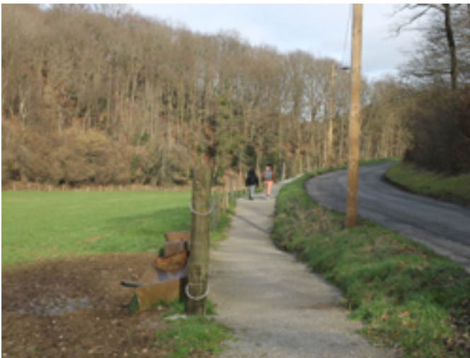
Retrait de la clôture de barbelés qui longeait la voie douce de la côte de Beauchêne, côté route. Ceci la rend plus esthétique et moins dangereuse pour les usagers.
