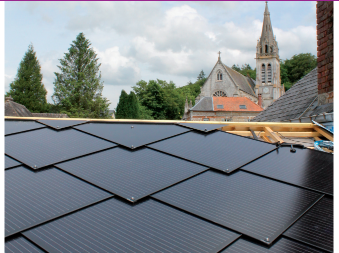
Travaux sur la toiture de la mairie : la Société ISOTOIT a retiré les ardoises et la vieille sous toiture pour poser un nouvel isolant et de nouvelles tuiles dont 80 m 2 sont photovoltaïques. La mairie est aujourd'hui quasi autonome niveau électricité grâce à sa production générée par le soleil.
