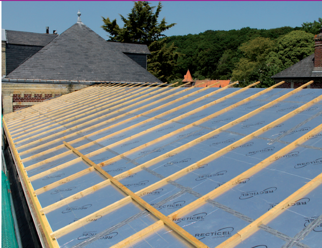
Travaux sur la toiture de la mairie : la Société ISOTOIT a retiré les ardoises et la vieille sous toiture pour poser un nouvel isolant et de nouvelles tuiles dont 80 m 2 sont photovoltaïques. La mairie est aujourd'hui quasi autonome niveau électricité grâce à sa production générée par le soleil.
