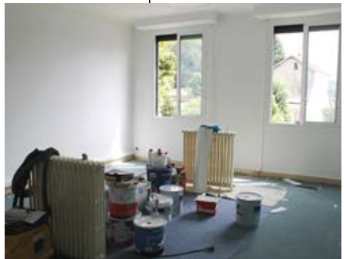
Aménagement d'un nouveau bureau administratif et d'une pièce conviviale au sein de la mairie, au niveau de l'annexe, suite à l'installation de l'agence postale communale.
