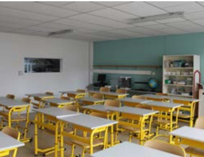
Peinture, rafraîchissement général et pose de stores dans certaines classes de l'école élémentaire.
