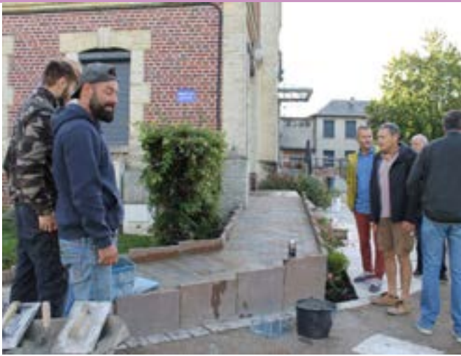
Un accès PMR (Personnes à Mobilité Réduite) a été réalisé pour un accès facilité à la salle des mariages. Un bel aménagement qui s'intègre parfaitement à son environnement.
