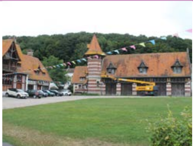
Démoussage complet de la toiture des deux bâtisses du Manoir. Entretien obligatoire pour éviter que les tuiles ne se déplacent à cause de la mousse et deviennent donc dangereuses.
