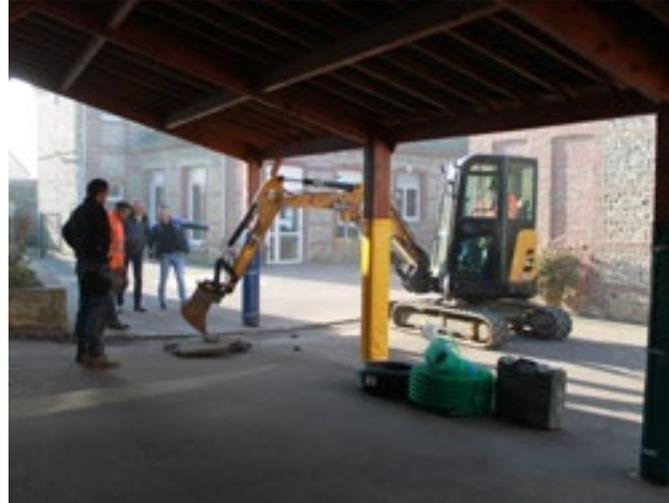
Suite à la découverte d'une fuite d'eau issue d'une canalisation d'alimentation souterraine vétuste à l'école maternelle, la mairie a aussitôt déclenché des travaux pour créer une canalisation bypass.
