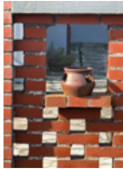
23 rue Waleran de Meulan
