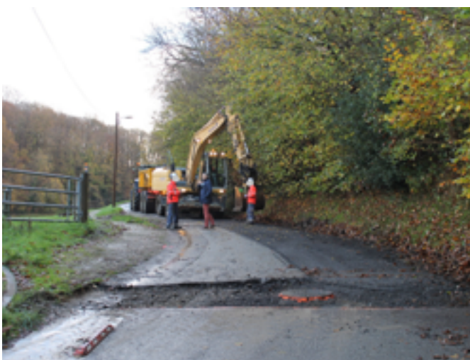
Réfection des enrobés de la route de la côte de Beauchêne sur 600 mètres linéaires (volume de 3 000 m 3 ) financée grâce au plan pluriannuel de Caux Seine aggro.
