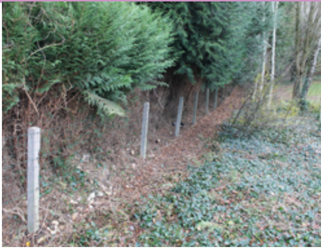
Pose de 40 mètres linéaires de grillage entre le Jardin Public et les habitations mobiles de la rue de la Roche.
