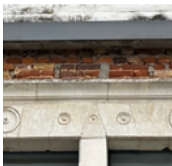
Haut du pignon Grande Halle, Abbaye du Valasse, au niveau de la zone attente livraisons
