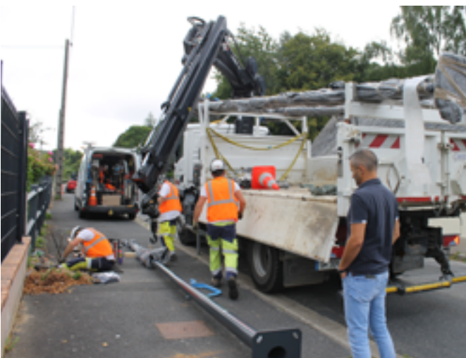
Installation des 100 candélabres dans les rues du quartier de la Roche.
