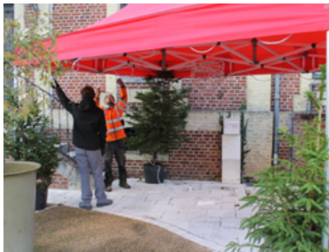
Installation électrique, matérielle et végétale des villages de Noël devant l'Hôtel de Ville et la fontaine Desgenétais.
