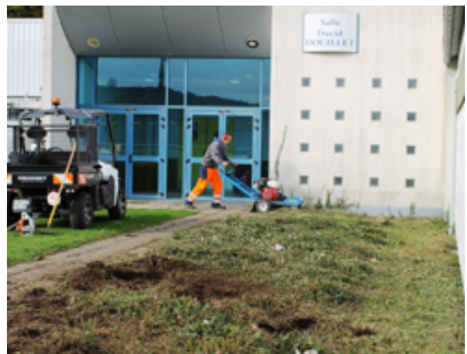
Suppression d'une vieille haie épineuse derrière la salle Claude Laplace et retrait des racines avec une rogneuse de souche pour ensuite semer du gazon.
