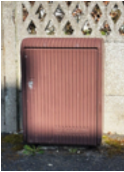
Contre la clôture du 1 rue de la Roche
